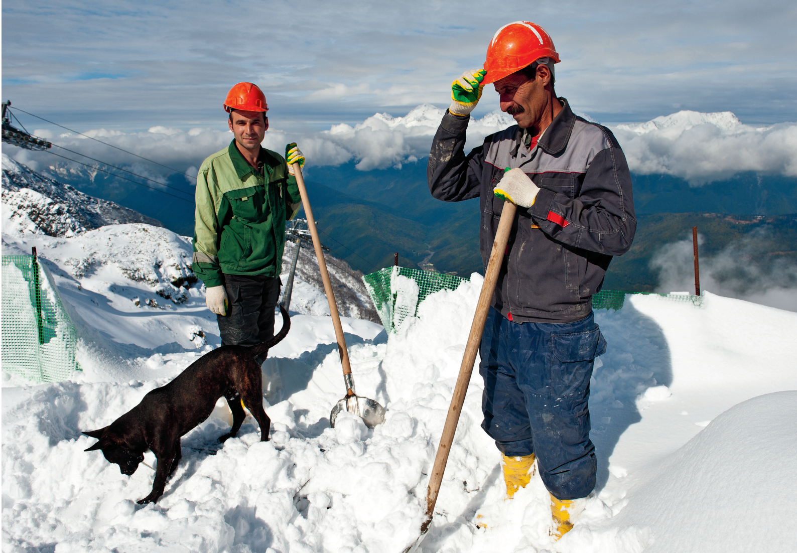
De båda turkiska byggnadsarbetarna Ibrahim och Osman bygger en restaurang på en av Kaukasus toppar inför OS i Sotji, 2 320 meter över havet. FOTO: ANDERS LINDH
